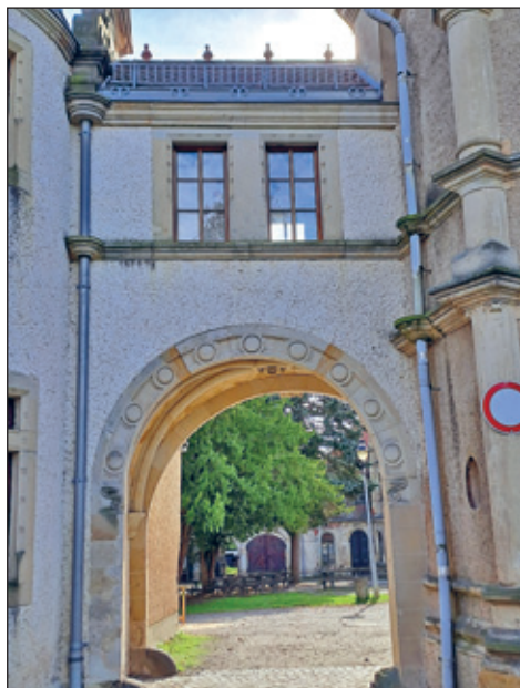
Erneuerung der Fenster der Pilgerherberge am Schloss Schönfeld
