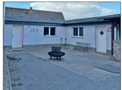
Erneuerung des Daches am Jugendclub Böhla b. O.
