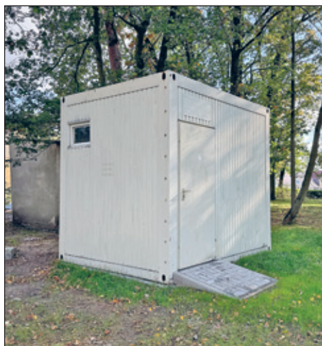
Herrichtung einer Fläche zum Aufstellen eines Sanitärcontainers auf dem Sportplatz Böhla b.O.
