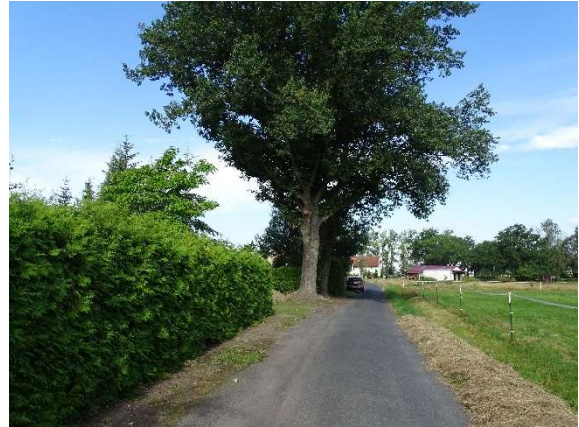
Abb. 3: Erschließungsstraße Wilhelm-Pieck-Straße (Blick Richtung Westen)
